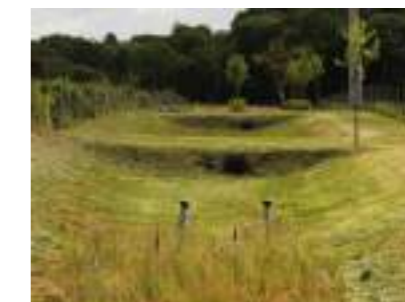
Langouët (27)_Bassin de rétention des eaux pluviales
