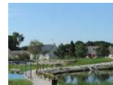
Saint -Etienne-de-Montluc (44)_Bassin de rétention
