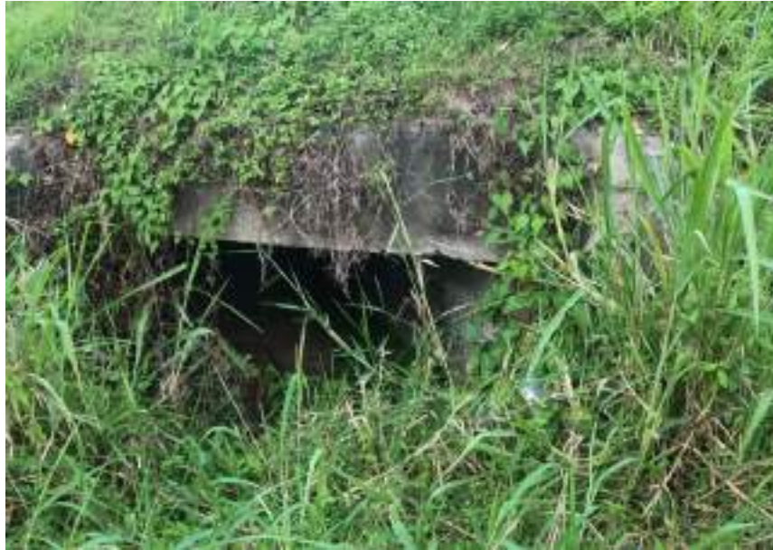
source : terrain 06/07/2021 Figure 39 : aval ouvrage 5
